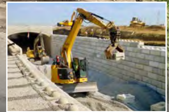
OUVRAGE D'ART, VOIRIE ET RÉSEAUX ROUTIERS
